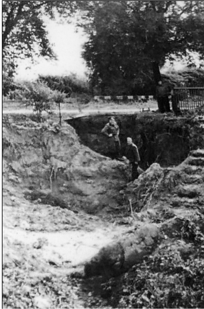
Abb. 4: Tagesbruch über dem Erdeborner Stollen am 7. Lichtloch (historische Aufnahme von 1965))
