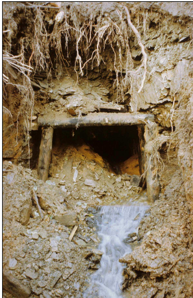
Abb. 5: Beim Öffnen des verbrochenen Mundloches eines alten Wismutstollens kam es zu einem plötzlichen Wasserausbruch mit intensiver Ockerbelastung
