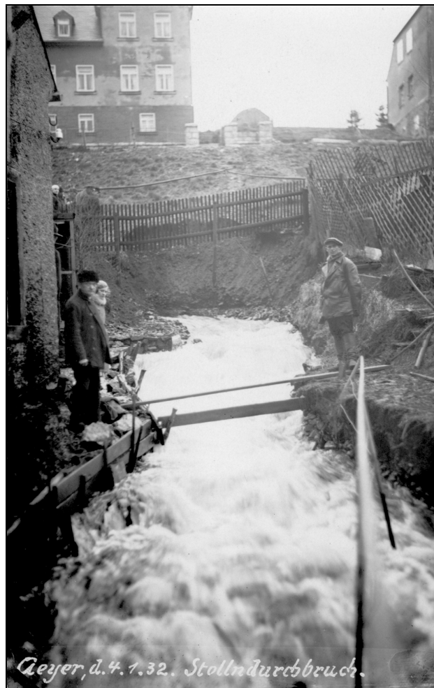
Abb. 2: Wasserausbruch über tagesnahe Abbaue am 04.01.1932 in der Bergstadt Geyer (historische Aufnahme)
